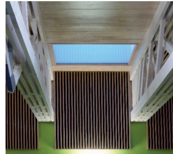
Spécialement dessinés par les architectes, des panneaux acoustiques en hêtre de différentes tailles sont disposés à des endroits précis afin d'assurer la meilleure absorption possible du son.
