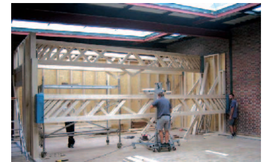
Une « boîte » composée de modules de murs à ossature bois de 140 cm x 60 cm soutient les poutres et s'insère dans l'enveloppe de briques existante.
